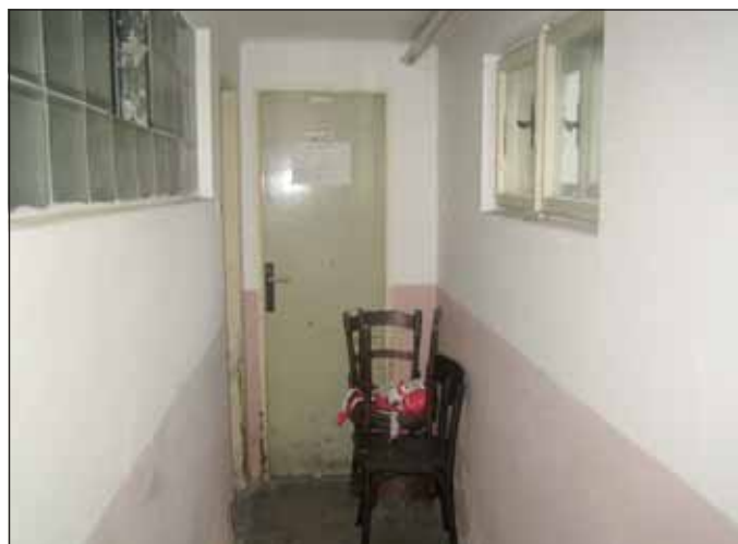
Fotografie byly pořízeny v únoru 2015, tedy v době ještě před zahájením rekonstrukce sokolovny.
