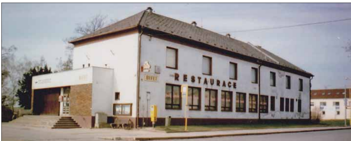
Opuštěný kulturní dům před demolicí v roce 2009.
