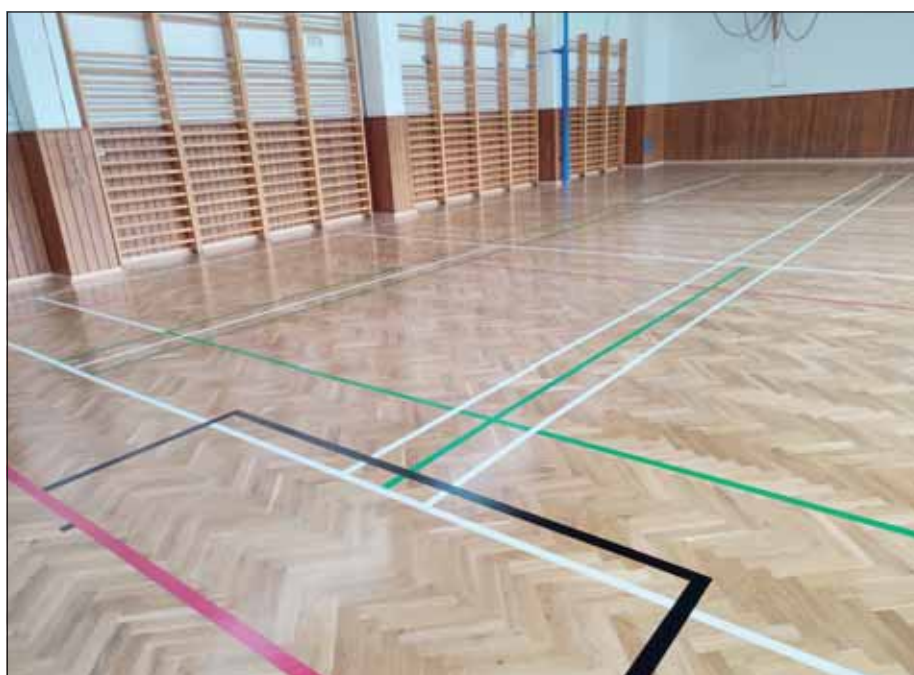
Modernizace podlahy v tělocvičně.
