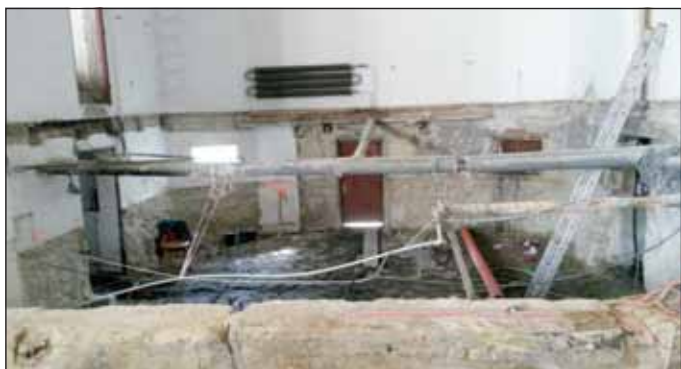
Rekonstrukce prostoru pod jevištěm pro nové šatny.
