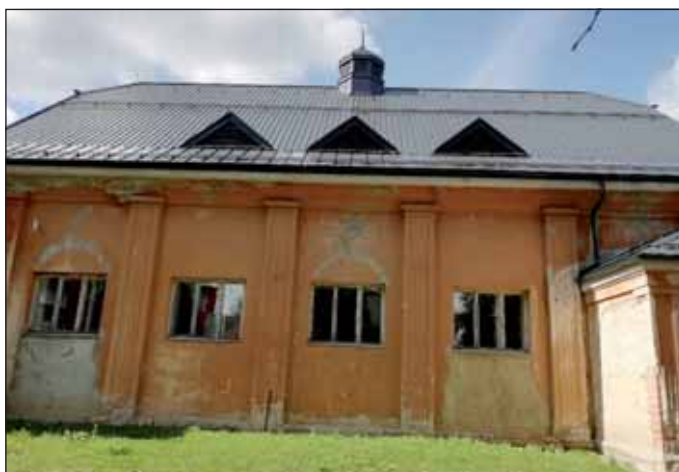
Nová střecha sokolovny.
