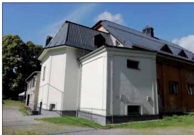
Zadní trakt sokolovny po rekonstrukci.
