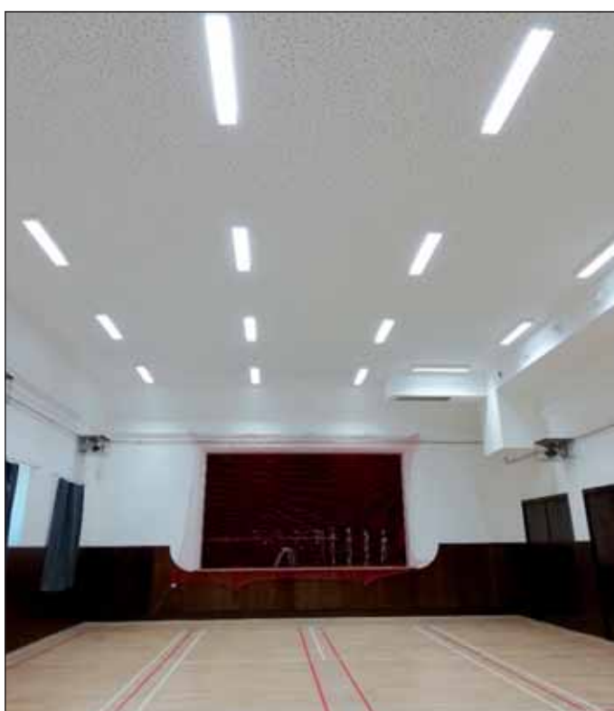
Rekonstruovaný velký sál s novým stropem, osvětlením a vzduchotechnikou.
