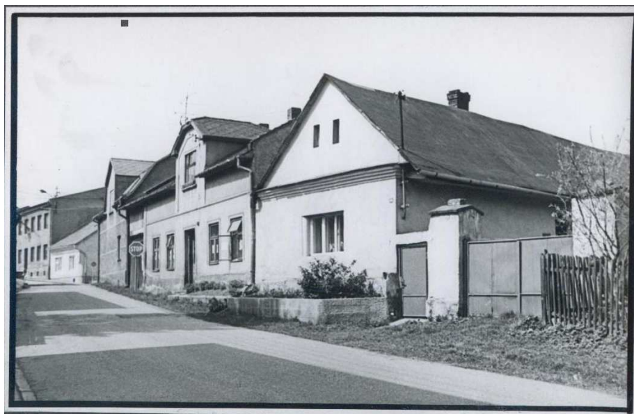
Ulice Čs. Legií v Klimkovicích
